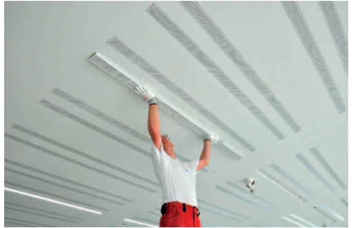
Einbau der Streifenabsorber zur Schallreduktion in die Decke mit Bauteilaktivierung
