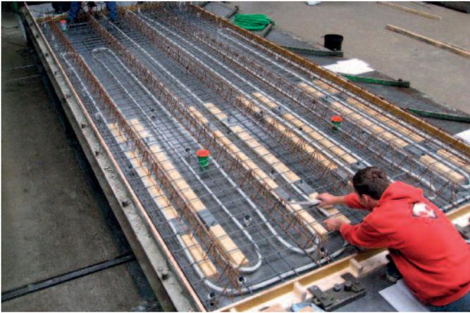
Vorgefertigte Deckenplatten mit zwei Rohrregistern für die Einzelraumregelung der Bauteilaktivierung. Sichtbar die Schalkörper für die Akustikabsorber
